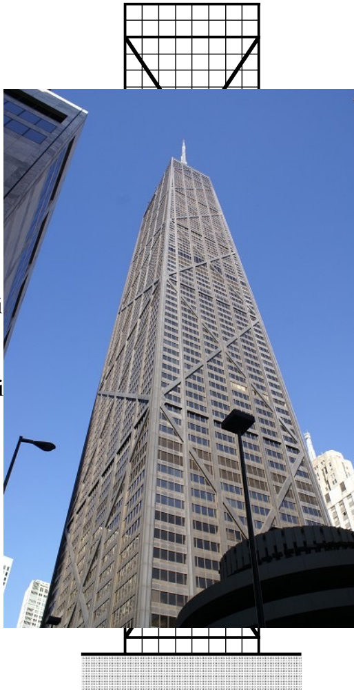
(b) Façades avec contreventement en treillis
